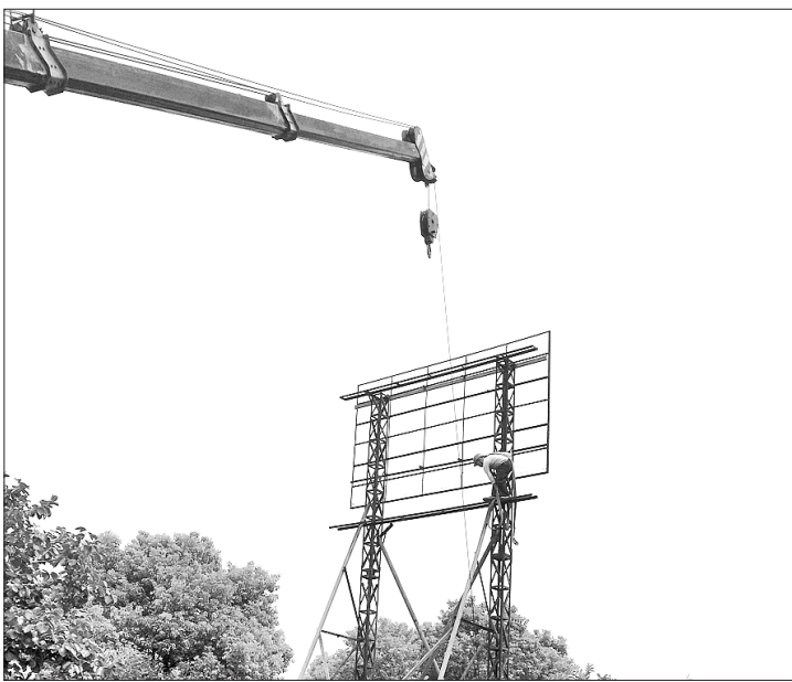
▲图为新河镇拆违工作人员正对陈海公路北侧一处违法构筑物实施拆除
