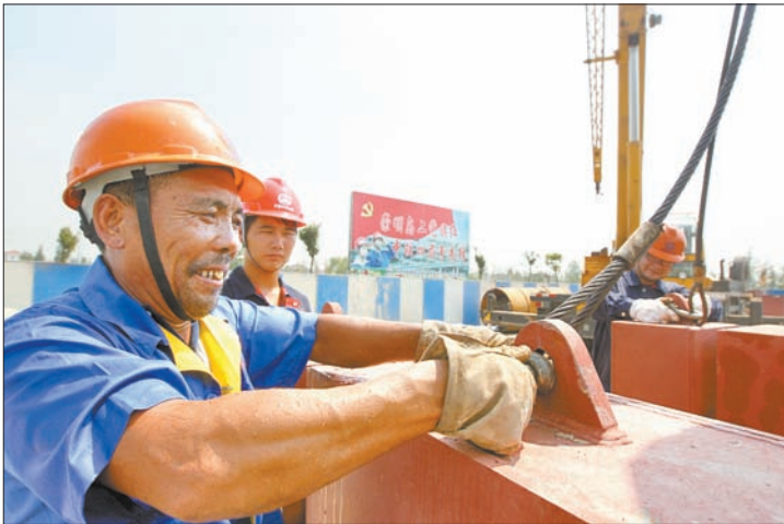
▲ 崇明岛原水输水系统一期工程建设3标段工地,施工人员顶着烈日作业
